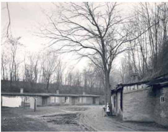
Notunterkunftsbauten im Wall von Fort X (Neusser Wall). Nach 1945
