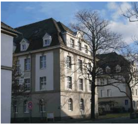
Seniorenhäuser der Riehler Heimstätten (ehemalige Infanteriekaserne). Ab 1927
