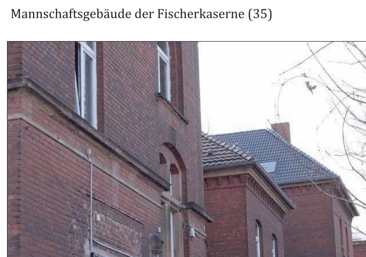
Mannschaftsgebäude der Fischerkaserne (35)
