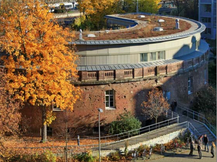
Fort V, sog. Rundbau (13 und 14)
