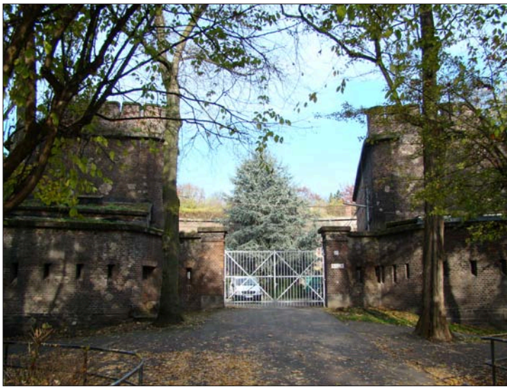
Zugang zum Kernwerk von Fort X (16 und 17)
