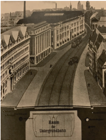
Gürzenichstraße mit U-Bahntunnel (1916). Quelle: Sammlung A. Hess
