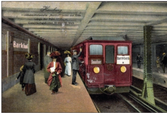
Die U-Bahnhaltestelle Mönkebergstraße, damals Barkhof, in Hamburg mit einem 2,56 Meter breiten Wagen um 1914 als Vorbild für Köln. Historische Ansichtskarte. Sammlung A. Hess
