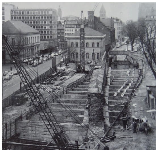
U-Bahnbau an der Römermauer zwischen Burgmauer und Zeughausstraße. Foto um 1963/64. Quelle: Bauen in historischem Boden, S. 45
