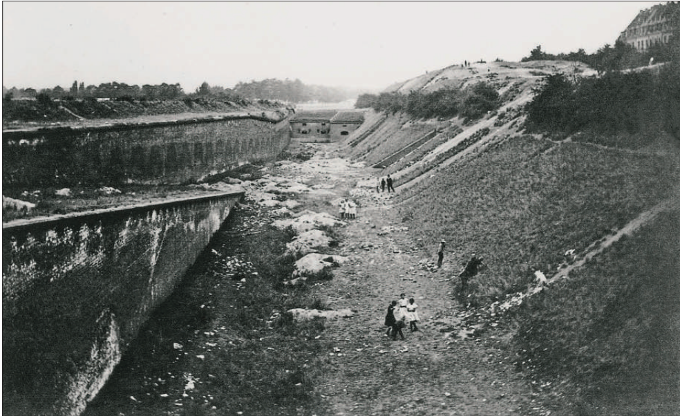
Blick von der Zülpicher Straße nach Norden in den Festungsgraben, der die Gleise der U-Bahn aufnehmen sollte. Foto um 1911. Quelle: Festungsstadt Köln, 2010
