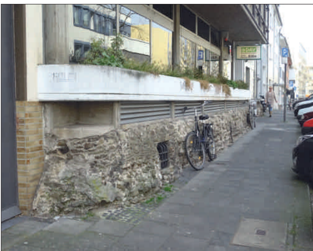
Unbemerkt bleibt dieses Teilstück der Römermauer als Sockelzone eines Hauses in der Clemensstraße. Foto: Alexander Hess, 2018
