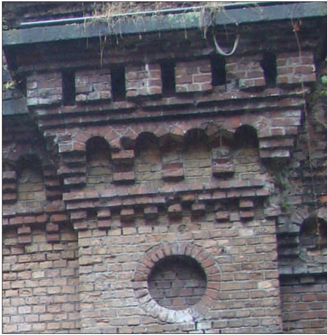
Backsteinfriese bilden das Kapitell der Pilaster. Detailfoto: Manfred Sabow, 2013
