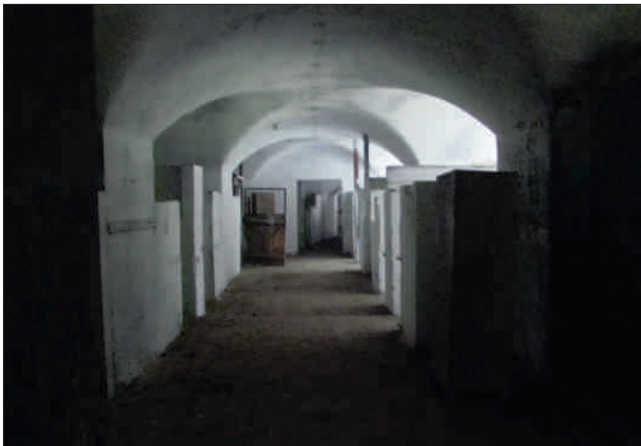
Der zu Pferdeställen umgebaute seitliche Quergang parallel zur Fassade. Foto: Manfred Sabow, 2013
