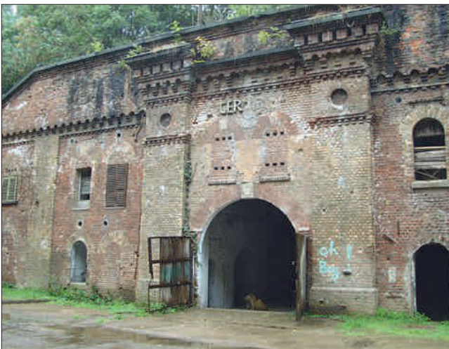
Fort IX - Tor der Kehlkasernen. Die Fensterländen, "vergesene" Kulisseneinbauten der Dreharbeiten sind inzwischen durch Vandalismus wieder zerstört (vgl. S. 7). Foto: Archiv Fortis Colonia, 2014
