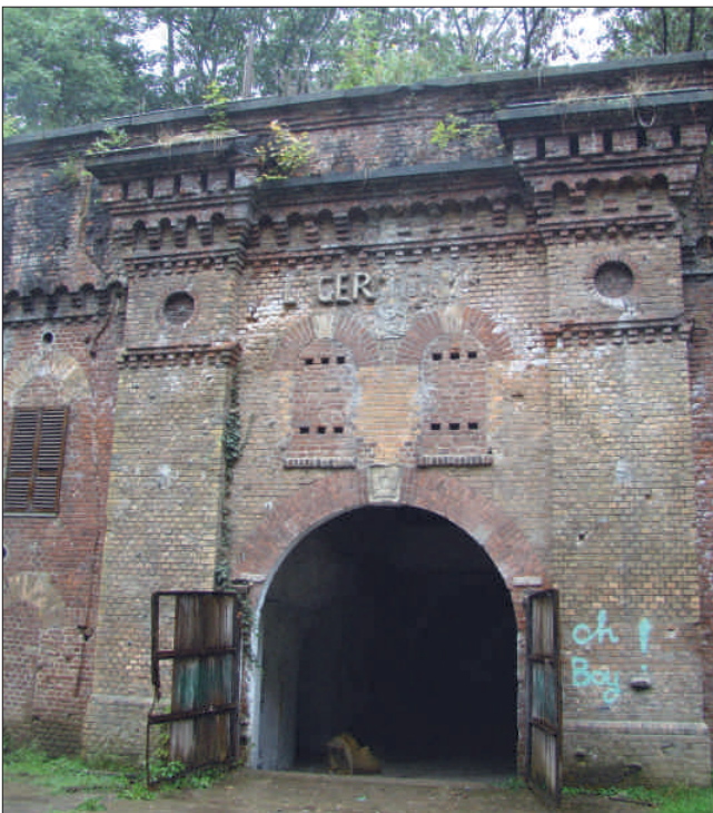
Fort IX. Das Tor ähnelt in der Gestaltung dem von Fort X. Auffällig ist die vertikale Betonung durch die Pilaster und die Backsteinfriese. Foto: Manfred Sabow, 2013
